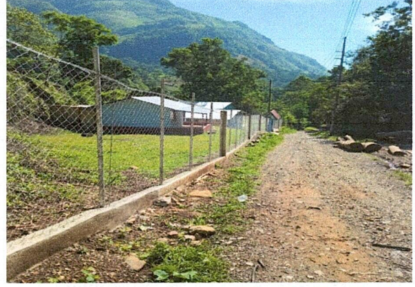
Foto 2: Culminación de muro Perimetral
