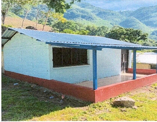
Foto 1: Culminación del cambio de techo
